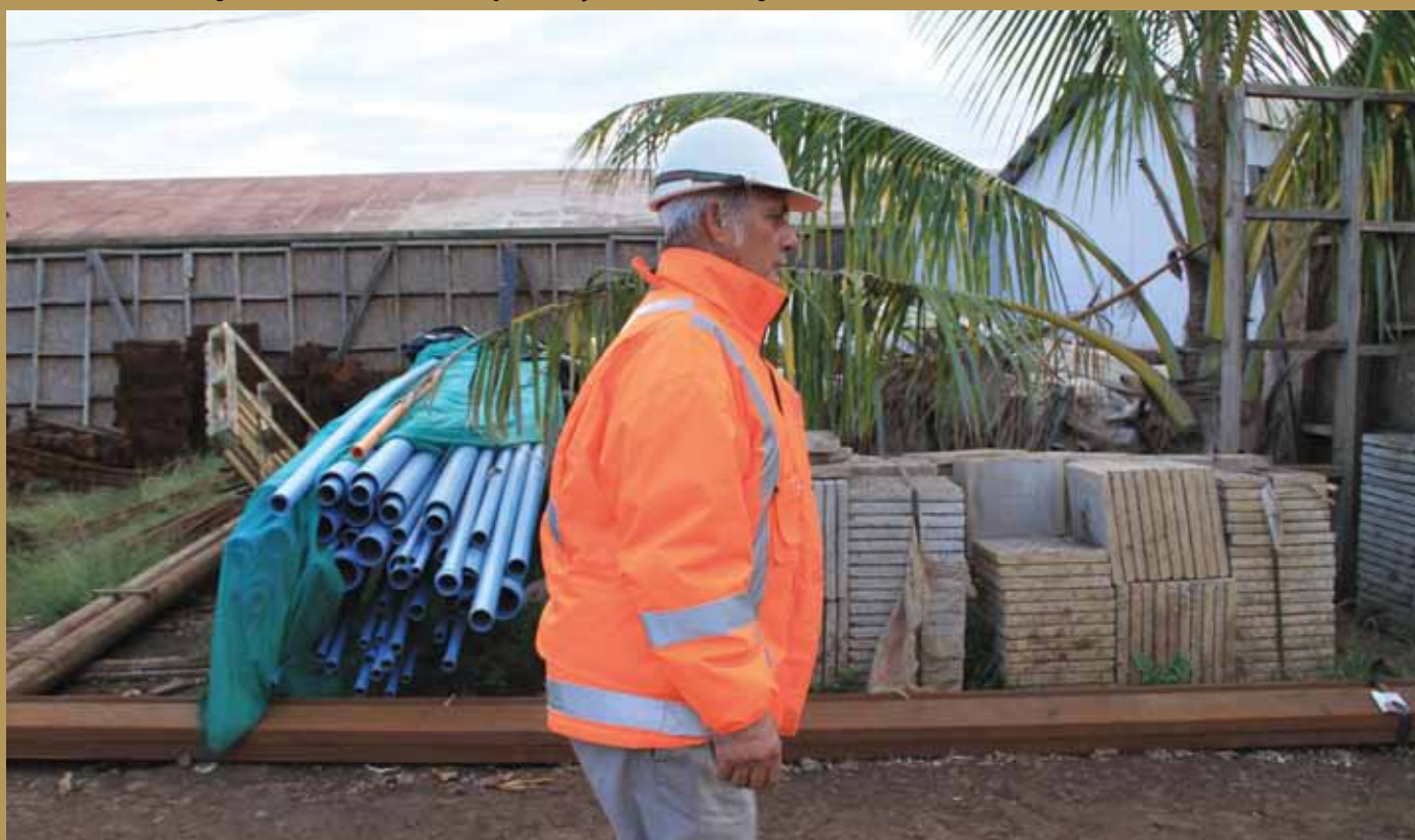
El Koro Kutu se dirige a la construcción en la que trabaja de nochera, vigilando las obras.
